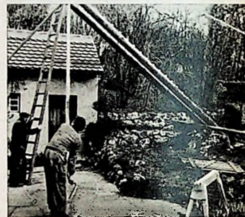
Abb. 11. Beim Aufstellen des Untermastes
